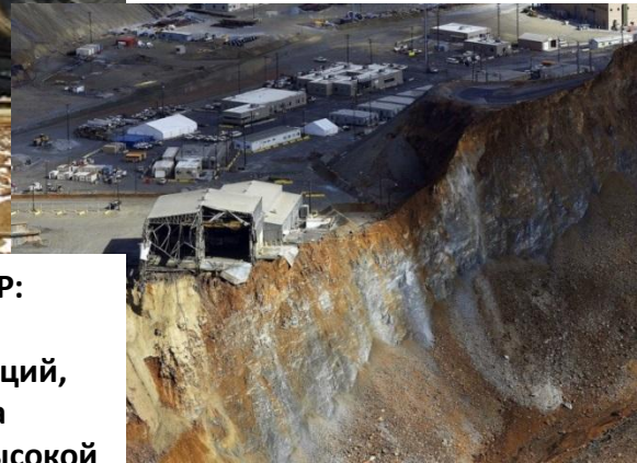
Последствия обрушения борта карьера «Бингем-Каньон» 12 апреля 2013 года (добыча медных руд, ш. Юта, США)
