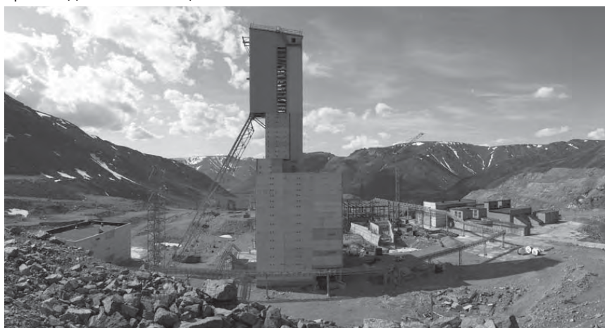
Панорама промплощадки Расвумчоррского рудника
